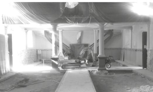
Près de 100 m<sup>3</sup> de terre, de gravas, de parquet ont ainsi été sortis, remplacés par 40 m<sup>3</sup> de tout-venant et 75 tonnes de béton pour la nouvelle dalle qui vient d'être coulée. Un carrelage va être mis en place devant les autels latéraux et la partie avant de la nef. Un parquet sera placé sous les bancs. Tant au niveau des murs que
